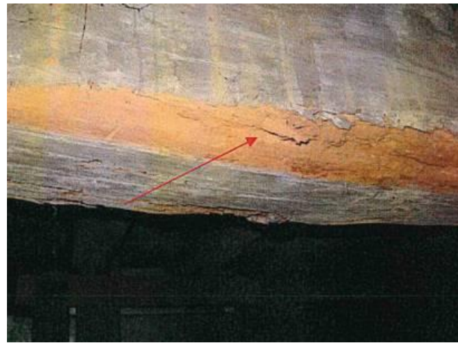
Figure 28 Solives reposant poutres 1 à 2 – Solive n°11 – Présences d'insectes à larves xylophage – Extrait rapport Apave
