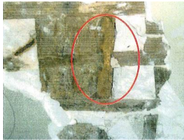
Figure 15 Sondage 1 - Attaques parasitaires solives – Extrait rapport Apave
