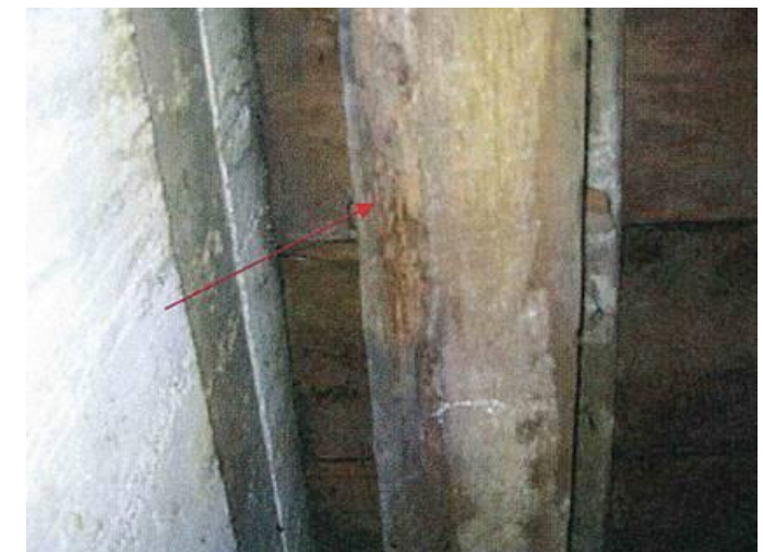
Figure 32 Solives reposant poutres 1 à 2 – Solive n°21 – Présences d'insectes à larves xylophage – Extrait rapport Apave
