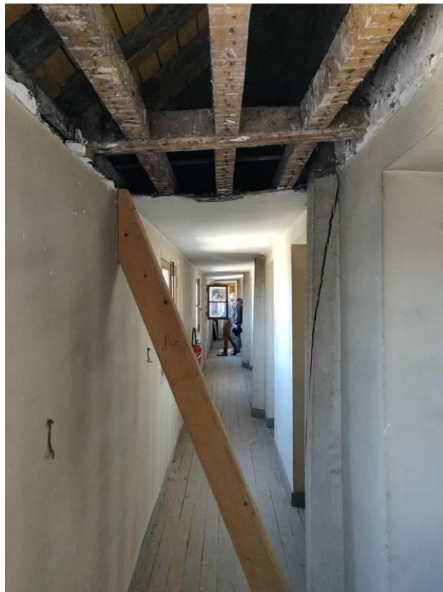
Photo 57 Niveau 3 ème balcon – Coursive côté rue d'Ulm très dégradée et étayée
