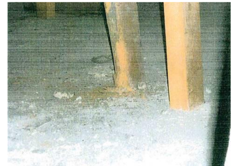
Figure 11 Pied de poteau dégradé – Extrait rapport Apave
