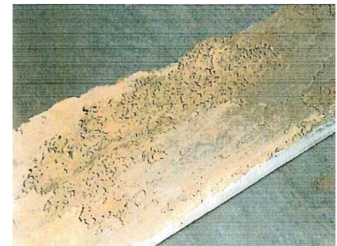
Figure 12 Plancher de l'escalier très dégradée – Extrait rapport Apave
