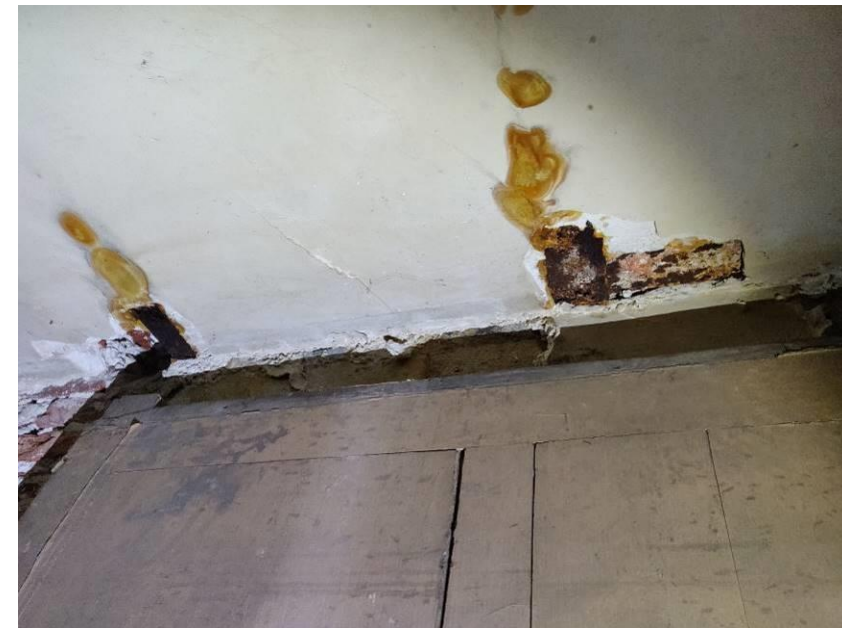
Photo 62 Plancher métallique arrière scène contre mur pignon très corrodé
