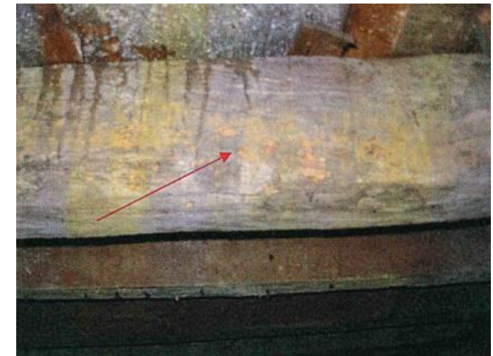
Figure 31 Solives reposant poutres 1 à 2 – Solive n°16 – Présences d'insectes à larves xylophage – Extrait rapport Apave
