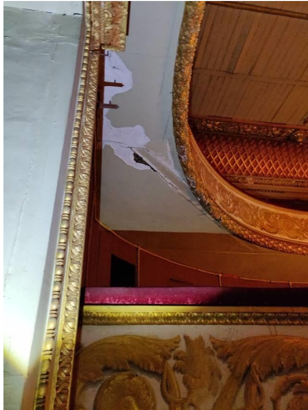
Photo 61 Sous-face 3 ème balcon – Dégradations du plafond plâtre (infiltrations ?)
