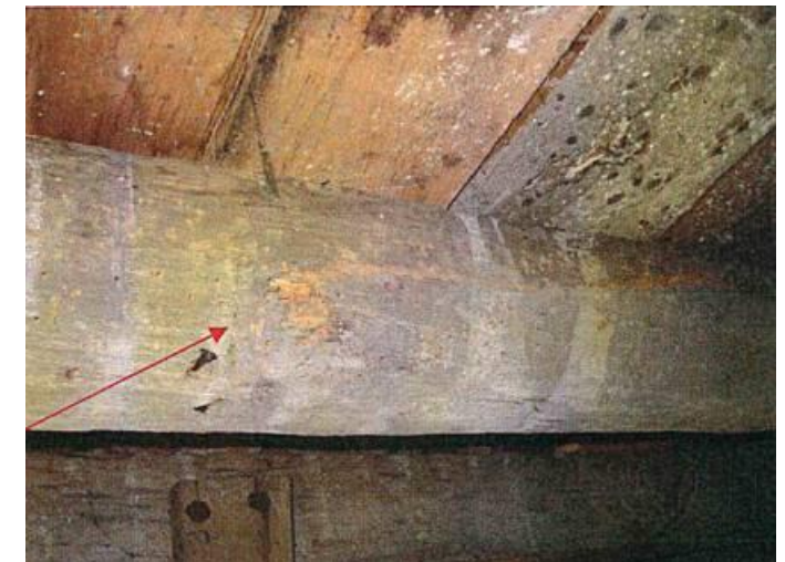
Figure 40 Solives reposant poutres 2 à 3 – Solive n°5 – Présences d'insectes à larves xylophage – Extrait rapport Apave
