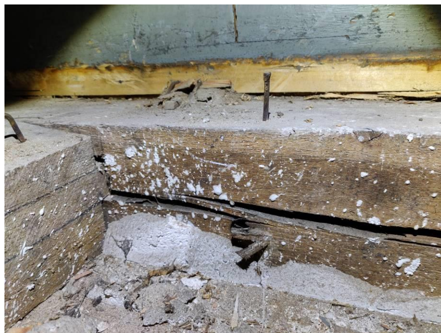
Photo 54 2 ème Balcon – Sondage S2 – Fissuration longitudinale de la poutre de rive
