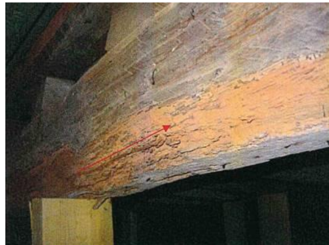
Figure 29 Poutre 1 – Présences d'insectes à larves xylophage – Extrait rapport Apave
