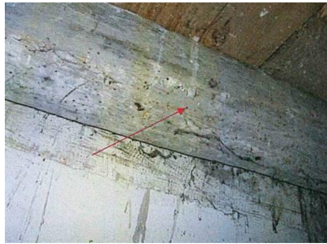
Figure 37 Solives reposant poutres 2 à 3 – Solive n°1 – Présences d'insectes à larves xylophage – Extrait rapport Apave
