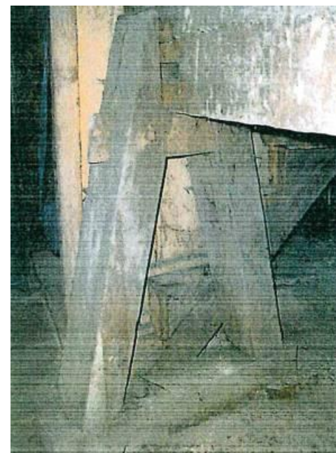
Figure 10 V inversé de reprise – Extrait rapport Apave
