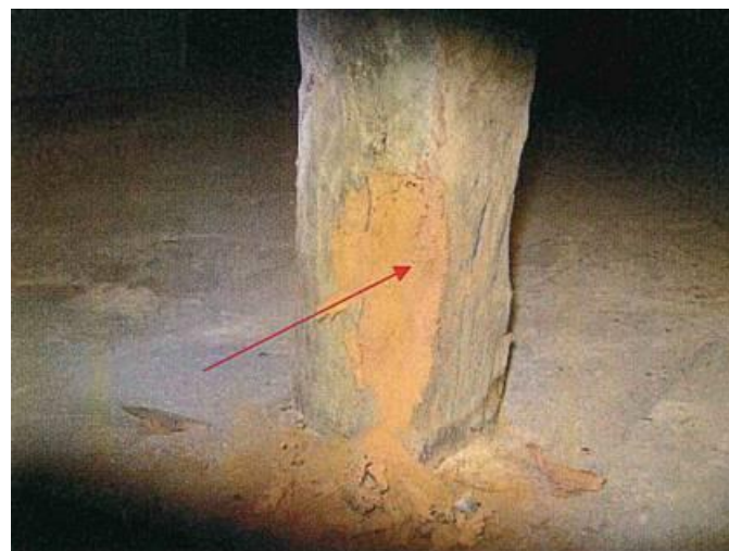
Figure 39 Solives reposant poutres 2 à 3 – Poteau solive n°2 – Présences d'insectes à larves xylophage – Extrait rapport Apave
