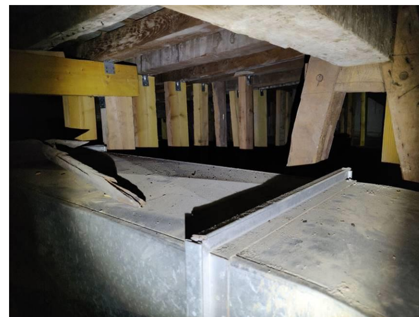
Photo 51 Parterre 0 – Vue de la structure porteuse – Renforcement en place avec pontage de la gaine – Restes (injecteurs) d'élément pour traitement des bois
