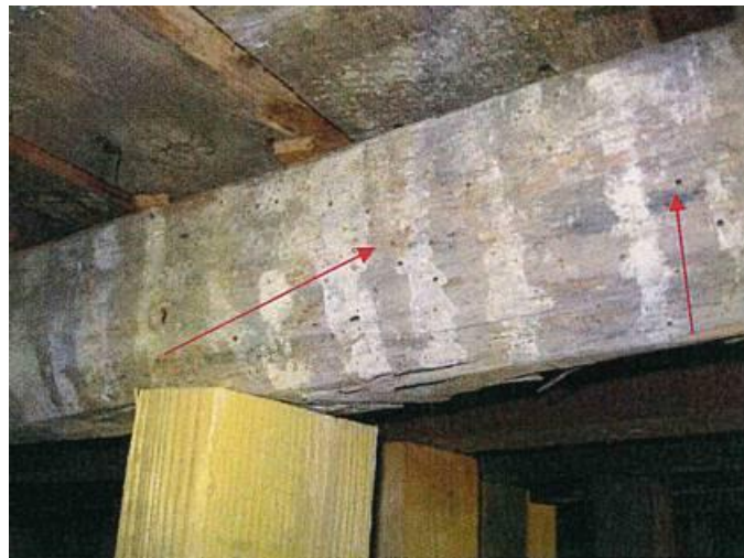
Figure 27 Solives reposant poutres 1 à 2 – Solive n°9 – Présences d'insectes à larves xylophage – Extrait rapport Apave
