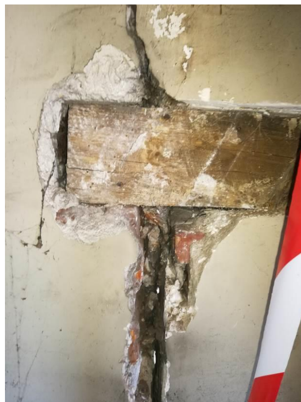
Photo 58 Niveau 3 ème balcon – Fissure montrant une faiblesse dans la liaison entre la structure en pan de bois des galeries et le mur de théâtre
