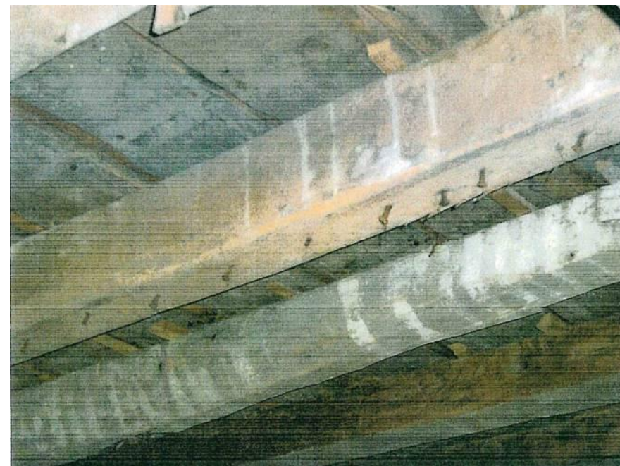
Figure 9 Attaques parasitaires solives – Extrait rapport Apave
