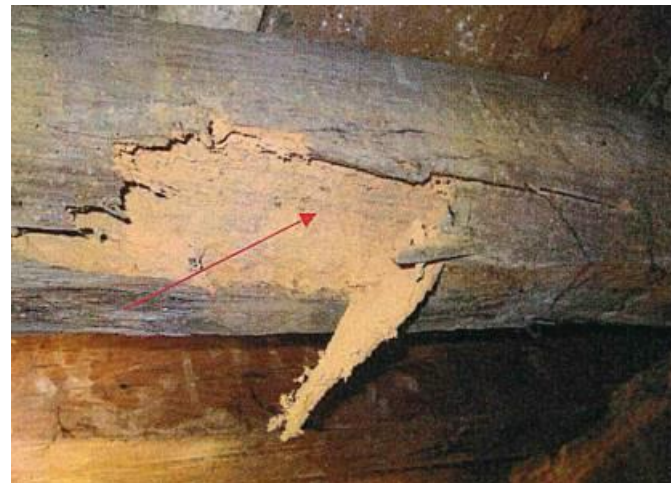
Figure 38 Solives reposant poutres 2 à 3 – Solive n°2 – Présences d'insectes à larves xylophage – Extrait rapport Apave
