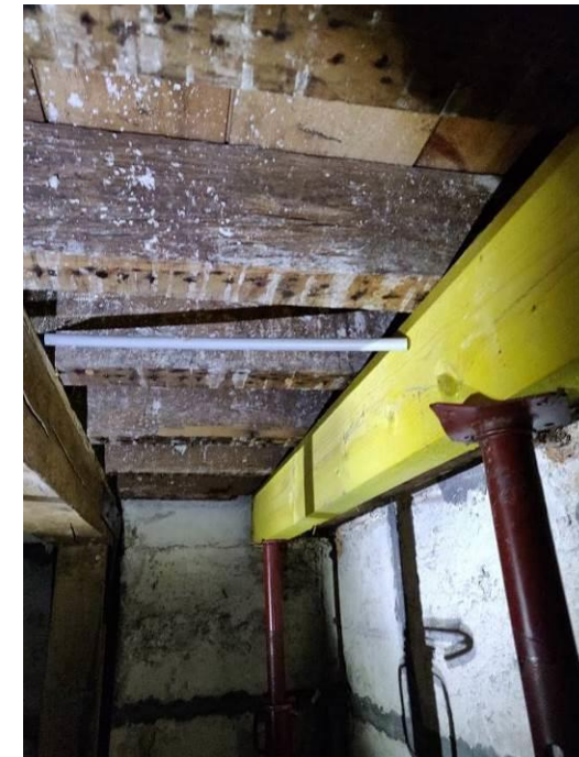
Photo 63 Plancher bois arrière scène contre mur pignon très attaqué – Etalement en place
