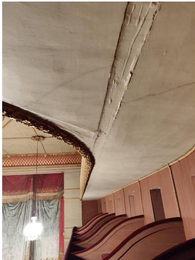
Photo 53 2 ème Balcon – Vue sous-face du 3 ème balcon – Dégradation de la peinture au droit de la structure bois
